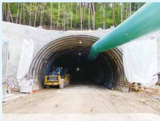
(仮称)山田トンネル 岡谷市側坑口
