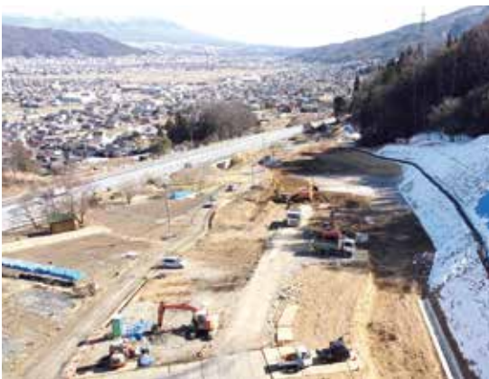
(仮称) 諏訪湖スマートICの工事状況
