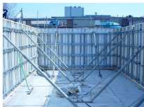
コンクリートパネルとしての使用例
