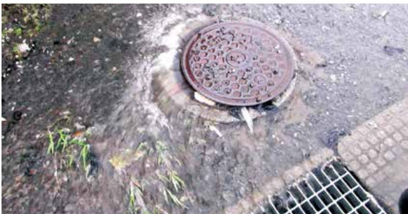
8月15日記録的大雨により、下水管に雨水が流入しマンホールから汚水があふれ出た。
