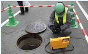
▲下水道管路点検の様子
