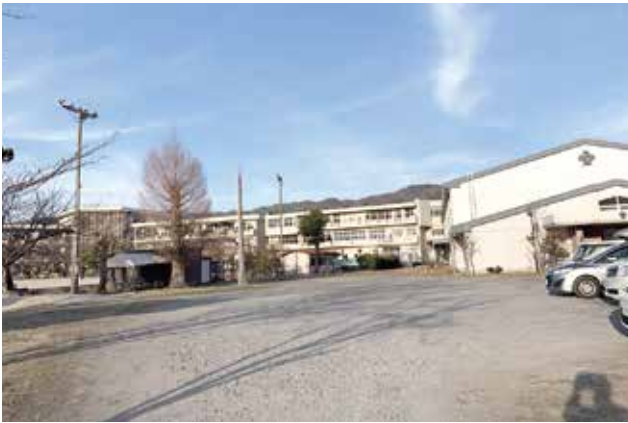
中洲小学校放課後児童クラブ専用棟建設予定地
