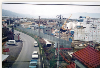
建設中の市博物館と県道岡谷茅野線 (平成2年)
