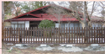
主屋 江戸時代後期の天保期(1830〜44年)に建てられた広大な建物が縮小を繰り返して、現在まで残されています。南側は新しい材料で増築されていますが、北側は江戸時代のままの姿を残しています(下写真参照)。
