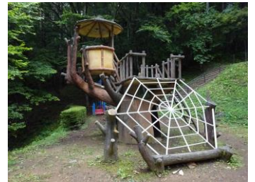
経過年数が長い、コンクリート擬木の複合遊具(立石公園)
