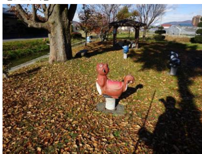
健全度C 摩耗・腐食 (宮川公園)
