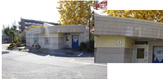
経過年数が長く劣化の進行した便所 (諏訪市湖畔公園)
