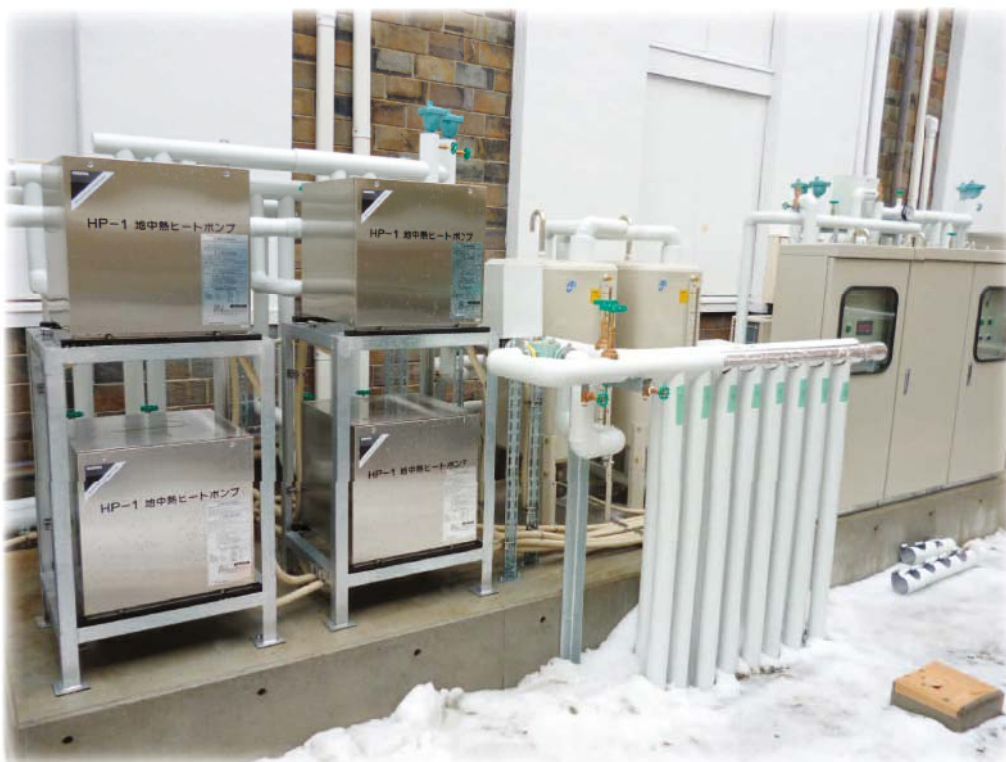
地中熱を利用した冷暖房システム
