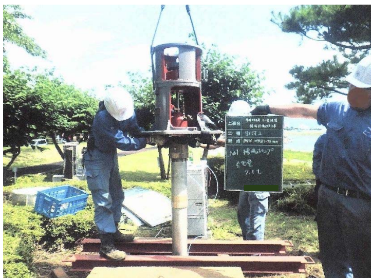
揚湯ポンプ改良工事の様子
