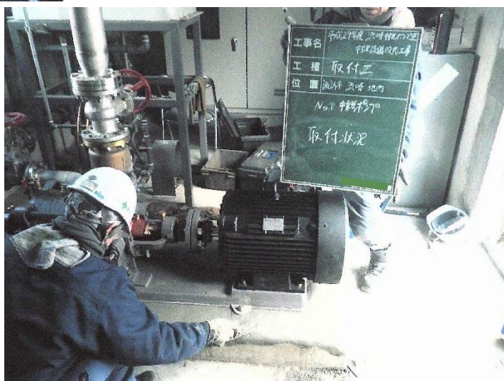
中継ポンプ改良工事の様子
